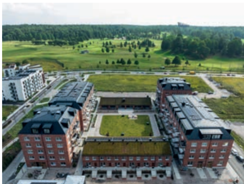
Hyresrättsprojektet Sportflygaren i Södra Ladugårdsängen i Örebro färdigställdes 2022. Det ligger i nära anslutning till grönområden, golfbanor och vandringsleder och samtidigt nära centrum. 180 hyresrättsbostäder är fördelade över fem huskroppar, varav fyra flerbostadshus och en långa med sex radhus. Här finns en mängd olika typer av bostäder: vindsvåningar, egen entré från gatan, extra generös takhöjd, snedtak eller takkupa.
