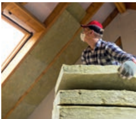
Holmström Fastigheter arbetar löpande med att tilläggsisolera fastigheternas vindar.
